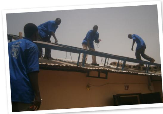
Fig 2 et 3. Installation des panneaux solaires sur le toit du centre de formation Aja Mali
